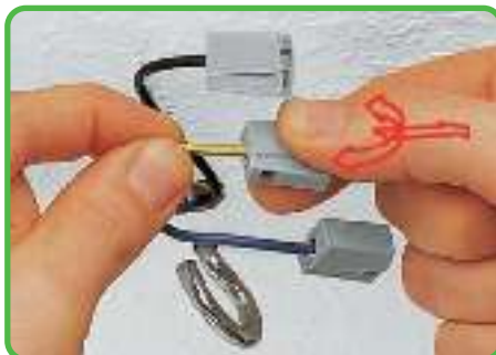
Отключение: удерживая проводник и прокручивая его вправо-влево, извлечь проводник.
