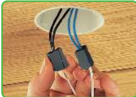
Выполнение соединения: полностью нажмите кнопку и вставьте зачищенный проводник в квадратное отверстие до упора, отпустите кнопку.
