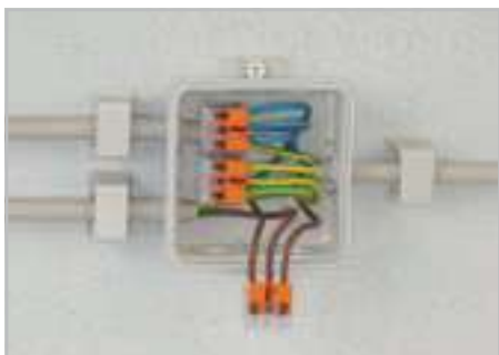
Электромонтаж тонких многожильных проводников в распределительной коробке.
